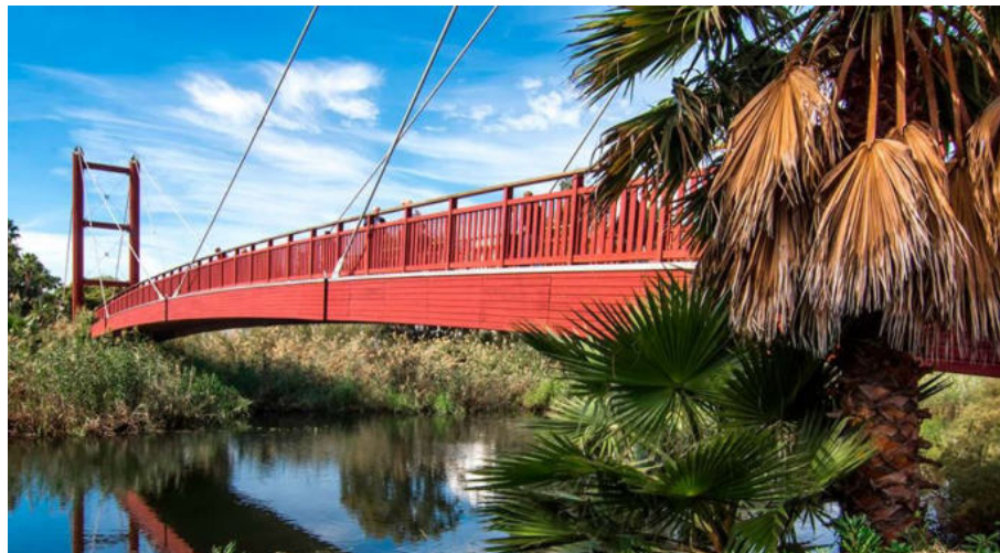
Figura 92: Puente sobre Río Verde
