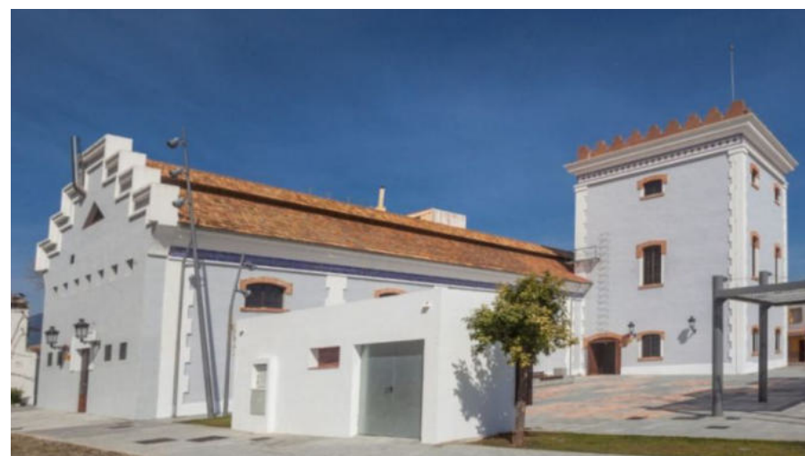
Figura 53: Trapiche de Guadaiza, reconvertido en Centro Cultural
