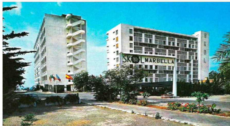
Figura 64: Edificio SKOL hacia 1964
