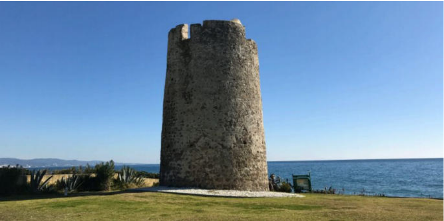
Figura 7: Torre de Las Bóvedas
