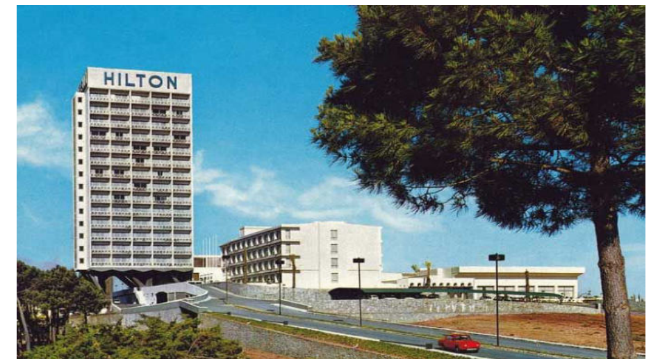
Figura 61: Acceso al antiguo Hotel Hilton
