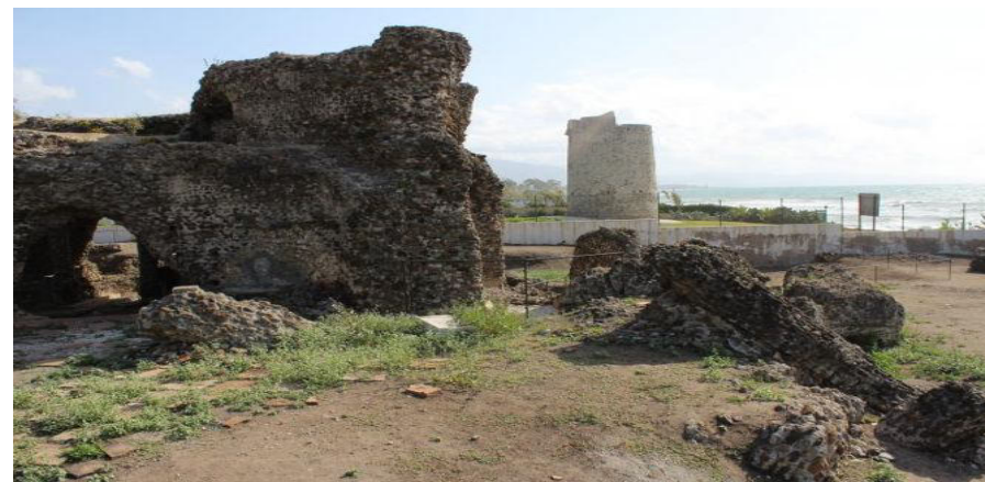
Figura 45: Torre de las Bóvedas tras las termas romanas de las Bóvedas
