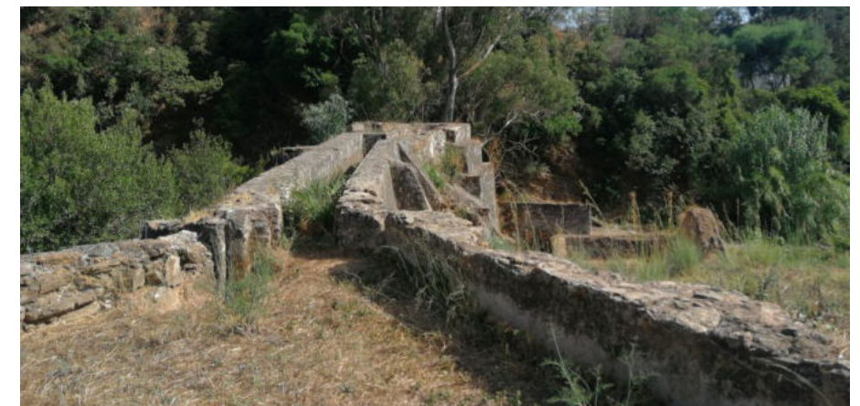
Figura 43: Construcción que derivaba el agua al interior del molino
